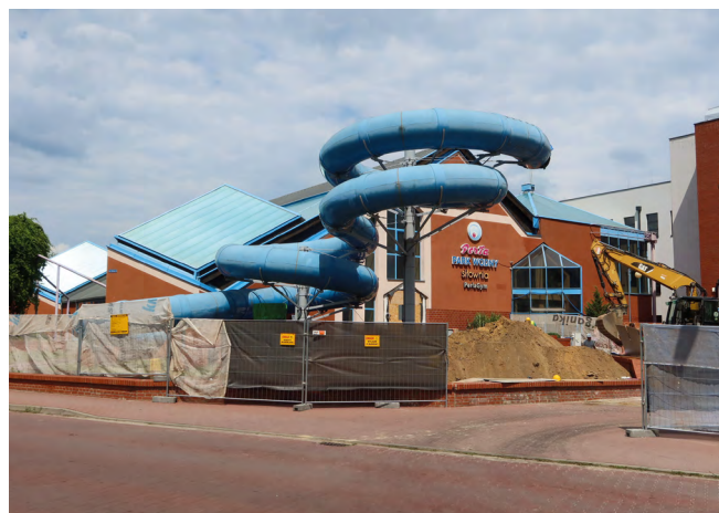
Prace związane z modernizacją wieży basenowej i łącznika idą pełną parą. Tak wyglądał demontaż elementów zjeżdżalni, która na czas realizacji inwestycji została wyłączona z użytkowania
