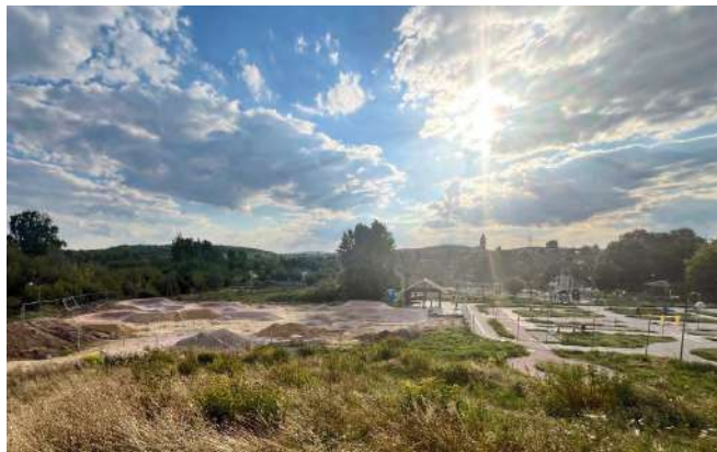
Budowa pumptracka w Nowinach nabiera tempa. Na placu widać już kształty toru, który wkrótce stanie się nową atrakcją sportową dla mieszkańców gminy
