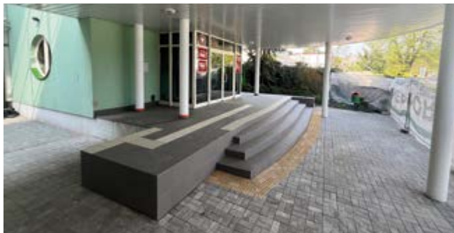
Prace przed Urzędem Gminy w Nowinach są już na zaawansowanym etapie
