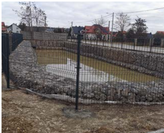
Nowy zbiornik na wody opadowe w Kowali
