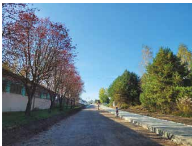
• Trwa rozbudowa drogi w Bolechowicach.
