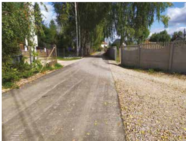
• Asfaltowa droga w Kowali.
