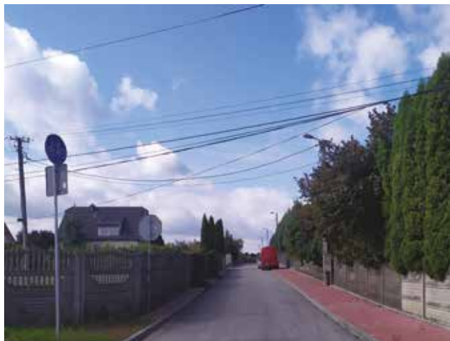
• Asfaltowa droga w Zgórsku.
