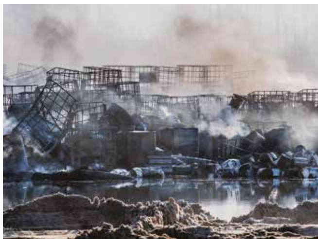
• Minął rok od pożaru składowiska przy ul. Perlowej.
