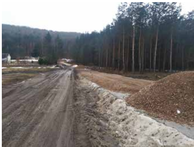
• Trwa wieloetapowa budowa ulicy Marmurowej w Szewcach.
