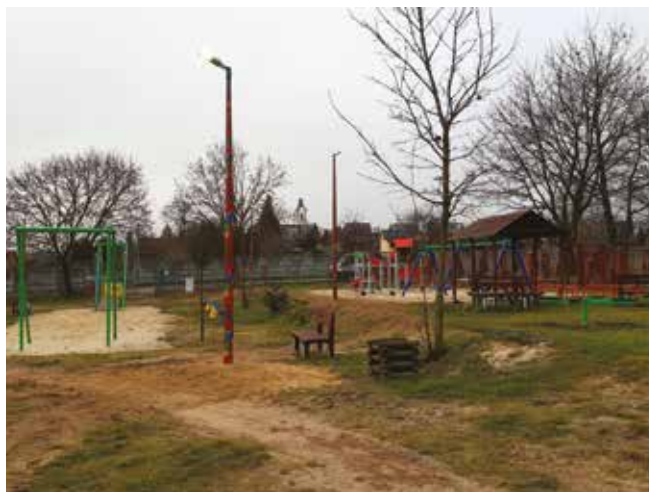
• Na placu zabaw w Nowinach zainstalowano oświetlenie...
