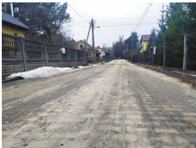
• Zmodernizowano nawierzchnię ul. Kolejowej w Trzciankach.
