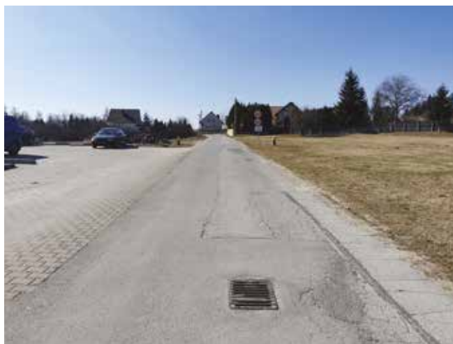
• W ciągu roku kolejny odcinek drogi zostanie przebudowany.
